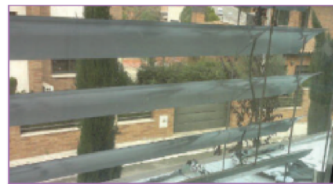
Tensor cable acero 5 mm, modelo Façade.
