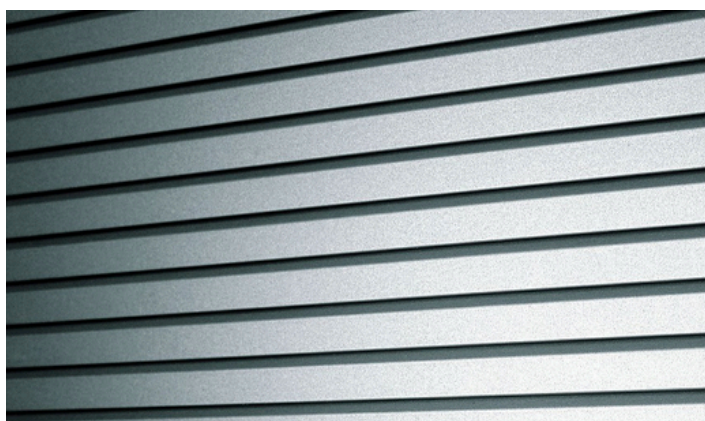
Lames tancades (vista des de l'exterior)
